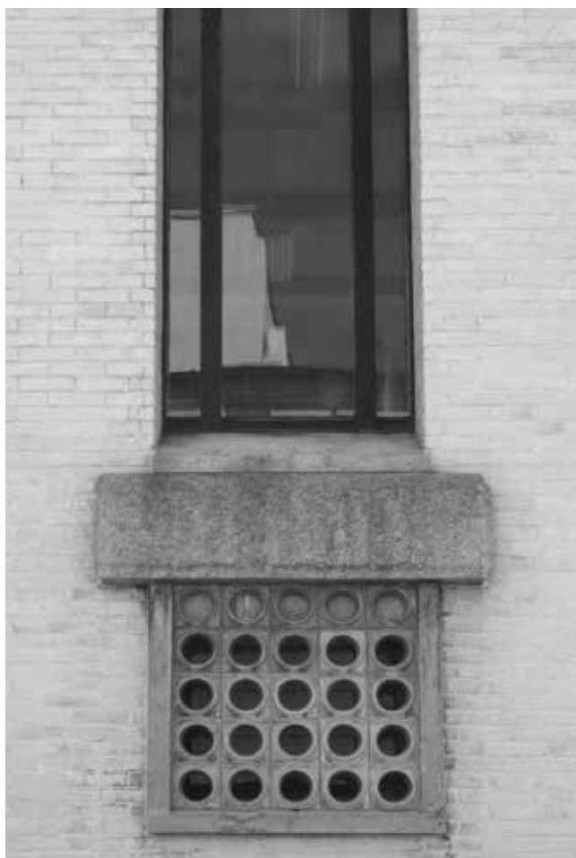
湯沢市 四同舎（旧湯沢酒造会館）
