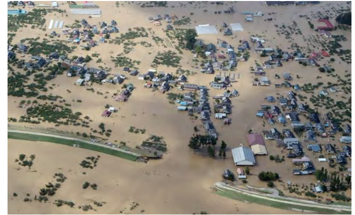
長野市長沼穂保での堤防決壊箇所
