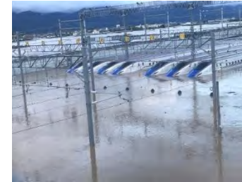
浸水した北陸新幹線車両基地
