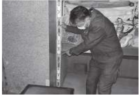
【浸水高さの確認 80cm（和室）】
