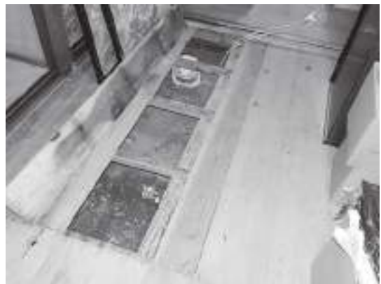
【和室床下】送風機による乾燥処置状況
