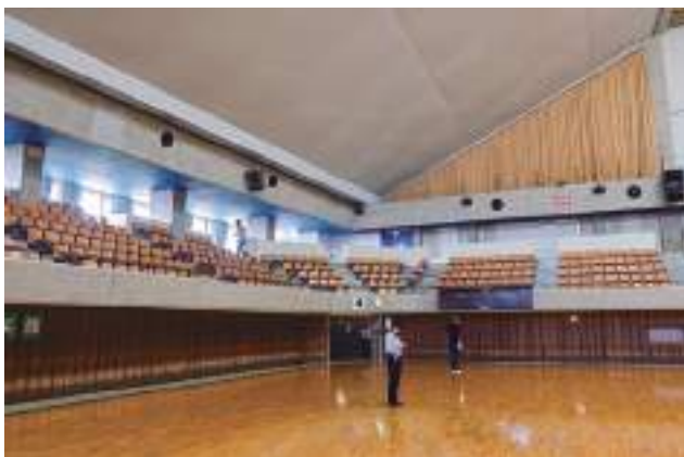
内部調査状況
