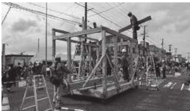
『のしろいち』タイニーハウスの柱建て
